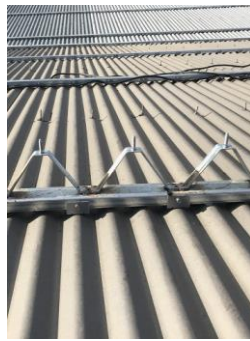
C鋼にタイトフレーム取り付け
