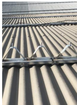
C鋼にタイトフレーム取り付け
